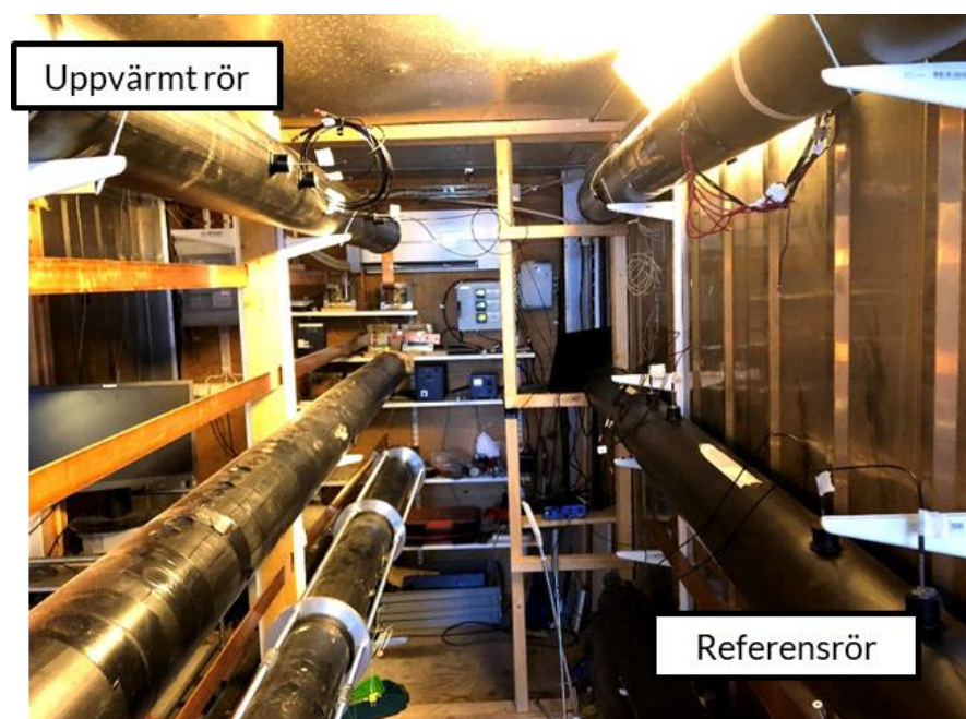
Figur 9: Ett långtidstest på RISE med två FV-ledningar, ett i rumstemperatur och ett med uppvärmt medierör vid 130 °C.
